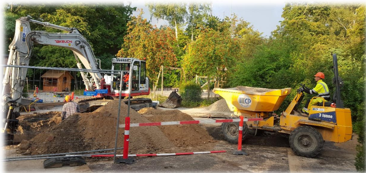
Nordvands entreprenør, Munck, går til den ud for Sandkrogens legeplads d. 4-9-2015
